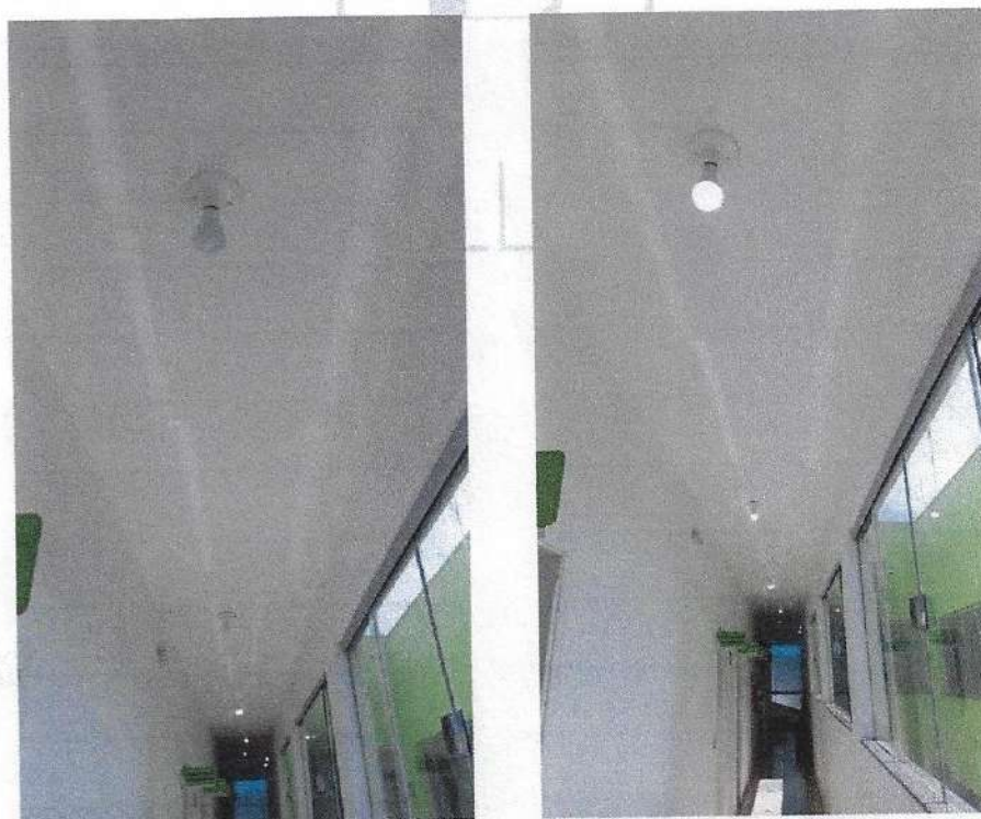
Conforme observado na primeira e segunda imagem, realizou-se a troca de 2 unidades de lampadas queimadas no corredor dos consultórios. Dia 15/11/2023
